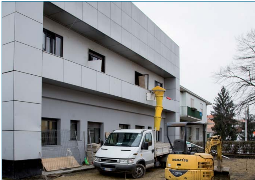
Comunità "Il Dado" di Settimo Torinese per l'inclusione abitativa di famiglie Rom - L'edificio in ristrutturazione
