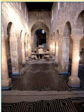
La navata centrale della cattedrale durante i lavori
