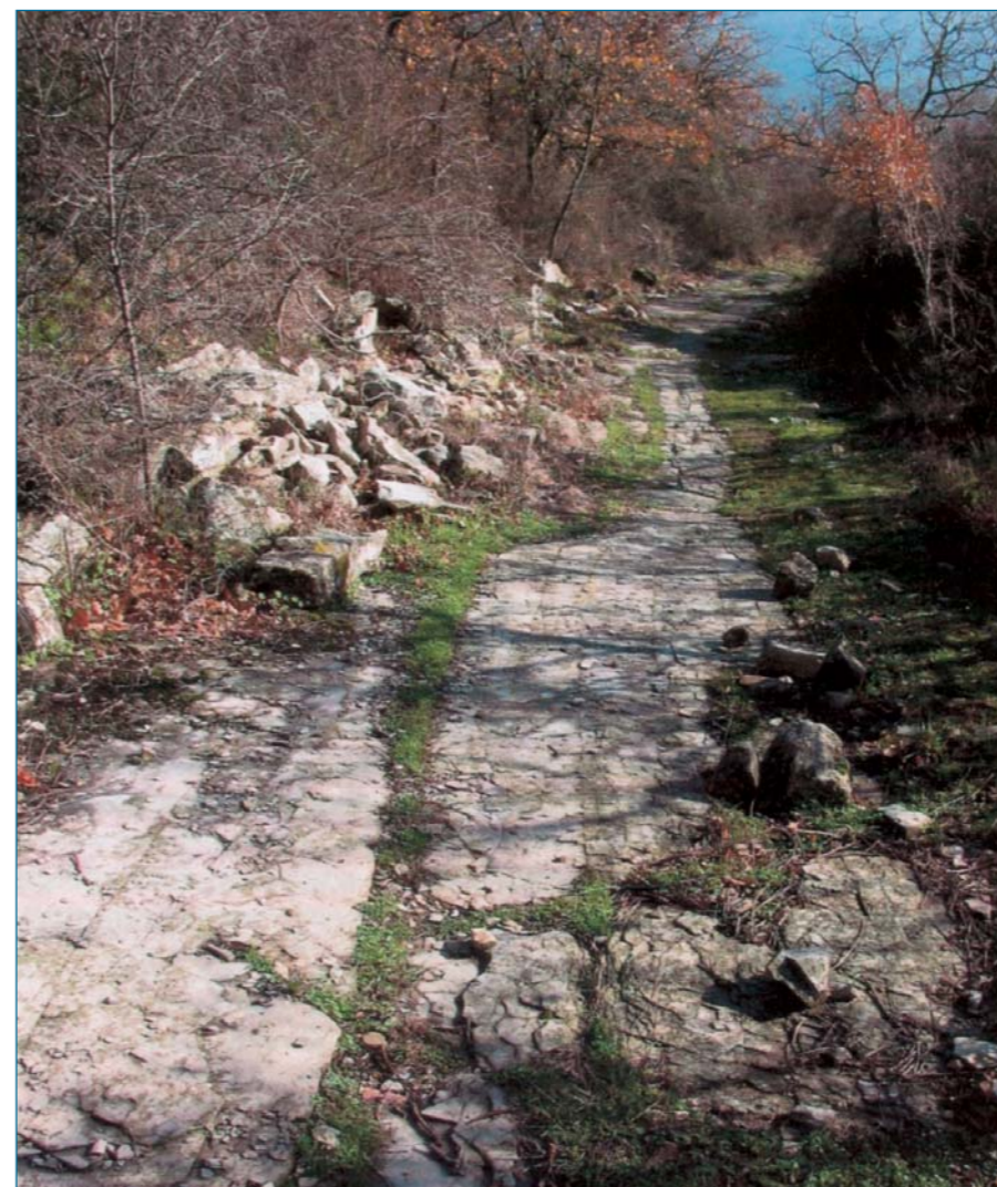
Cavagliano. Particolare della pavimentazione lapidea
