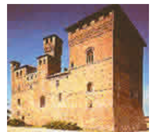
Il Castello di Grinzane Cavour, Alba (Cuneo)
